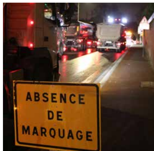
↑ L'enrobé est acheminé à la chaîne par une vingtaine de camions. À l'intérieur, l'enrobé est gardé au chaud à une température comprise entre 110 à 150 degrés.
