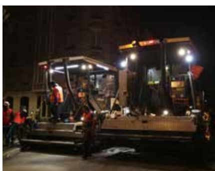
↑ Deux finisseurs seront nécessaires pour déverser les 600 tonnes d'enrobé cette nuit-là.
