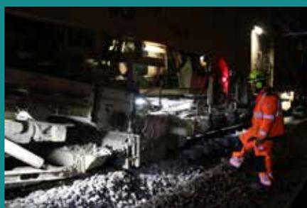
↑ **Le bourrage** : cette étape est effectuée avec une machine appelée « la bourreuse ». Elle mélange le ballast et le tasse afin d'égaliser et stabiliser la voie.
