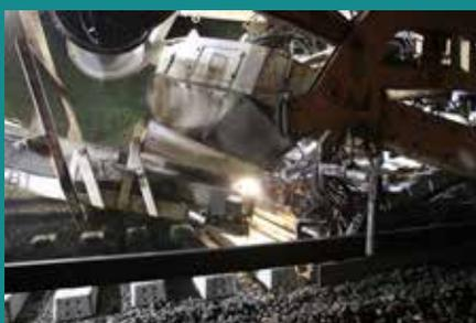
↑ **Le relevage** : de nouvelles traverses (en béton) seront ensuite positionnées et fixées aux rails. Le train usine y déversera par la suite le nouveau ballast.
