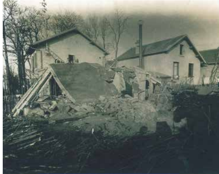
Bâtiments détruits au 49, rue des Bruyères
