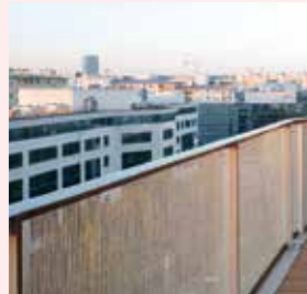
Daquin Ferrière & associés - Résidence de l'Aqueduc - 2015 Gentilly © Daquin & Ferrière architecture
