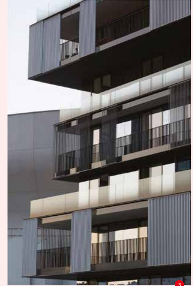
ECDM - ZAC des Coteaux - 2014 Arcueil © Benoit Fougeirol Portée du balcon jusqu'à 3 m
