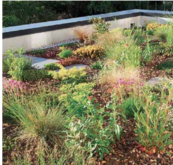
Toiture terrasse végétalisée
