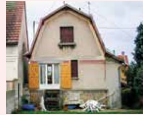
Latitude 48 Architecture Rénovation BBC de la maison Effinergie Morsang-sur-Orge © latitude 48°
