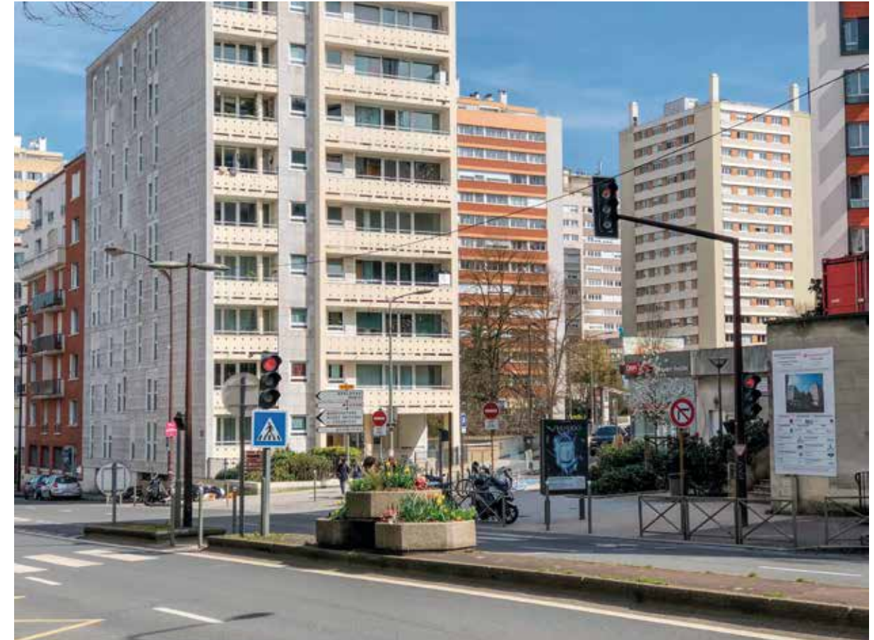
Immeubles construits dans les années 80
