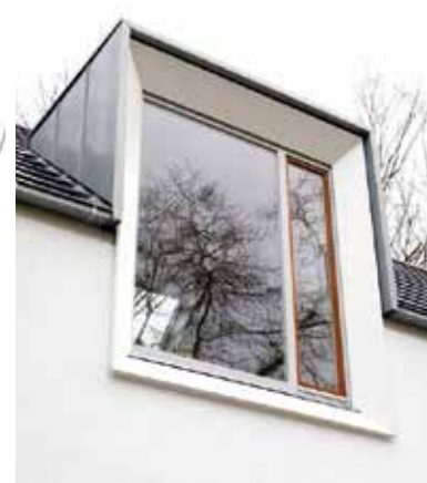
Immeuble d'habitation à Kirchdornberg © DR
