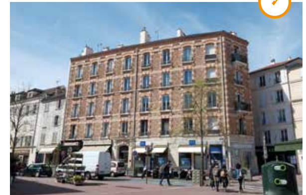
Logements collectifs 72 Grande rue
