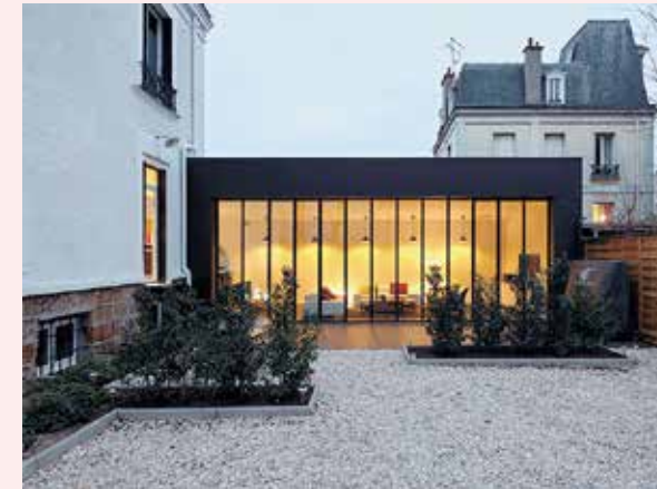
Alexandre Hordé Architectes Bois-Colombes © Thomas Lannes
