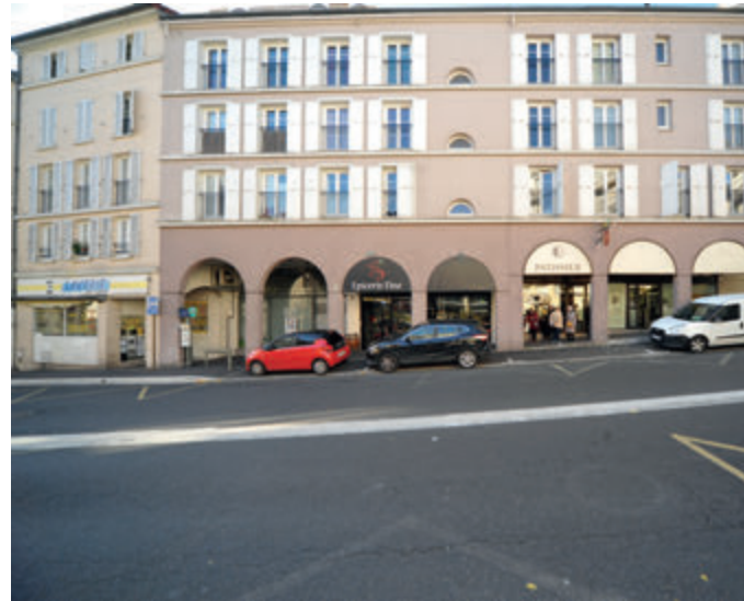
Du 5 au 15 rue de la ville-d'Avray : Arcade arc plein cintre et galerie
