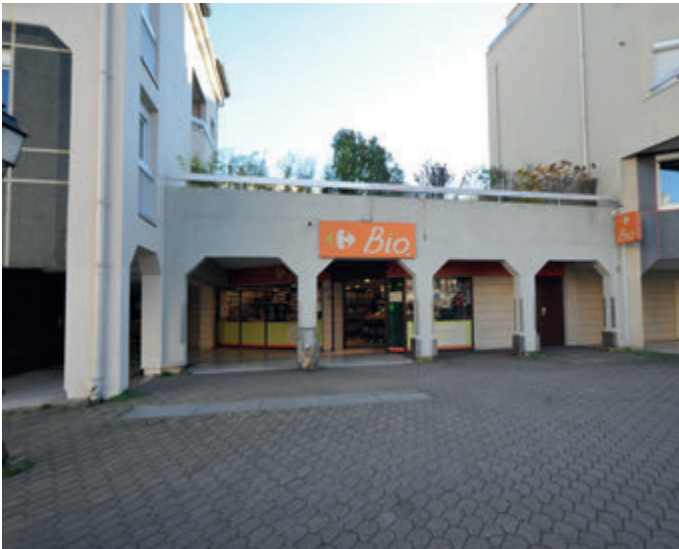
85 Grande Rue : Arcade avec arc surbaissé et galerie
