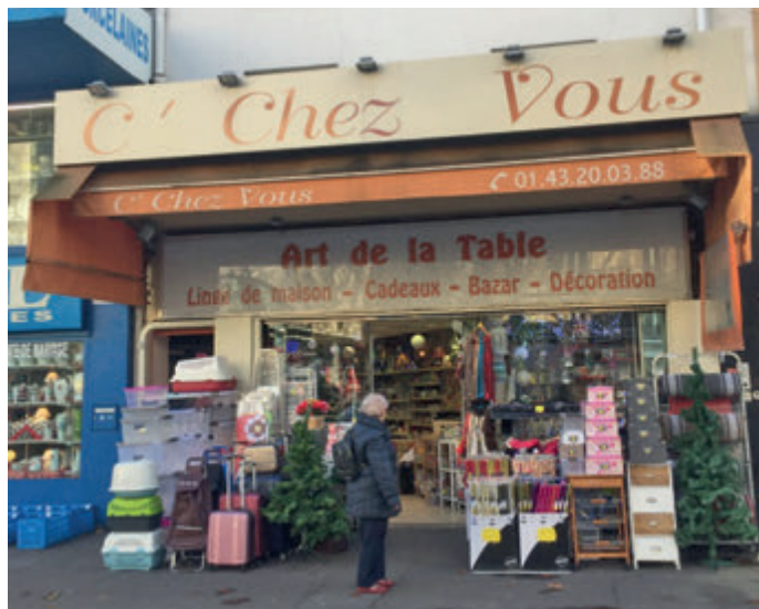
Déconseillé : enseignes trop nombreuses et trop imposantes, caisson
