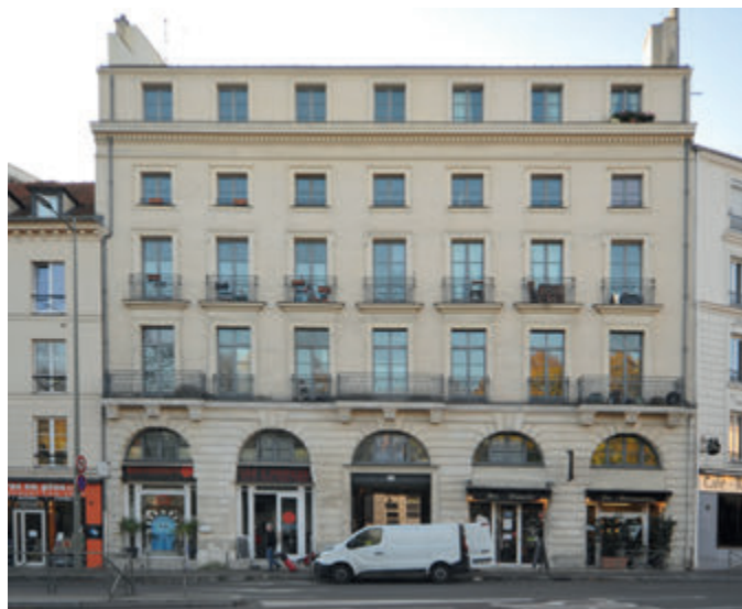
3 Grande Rue : Arcades composant la façade
