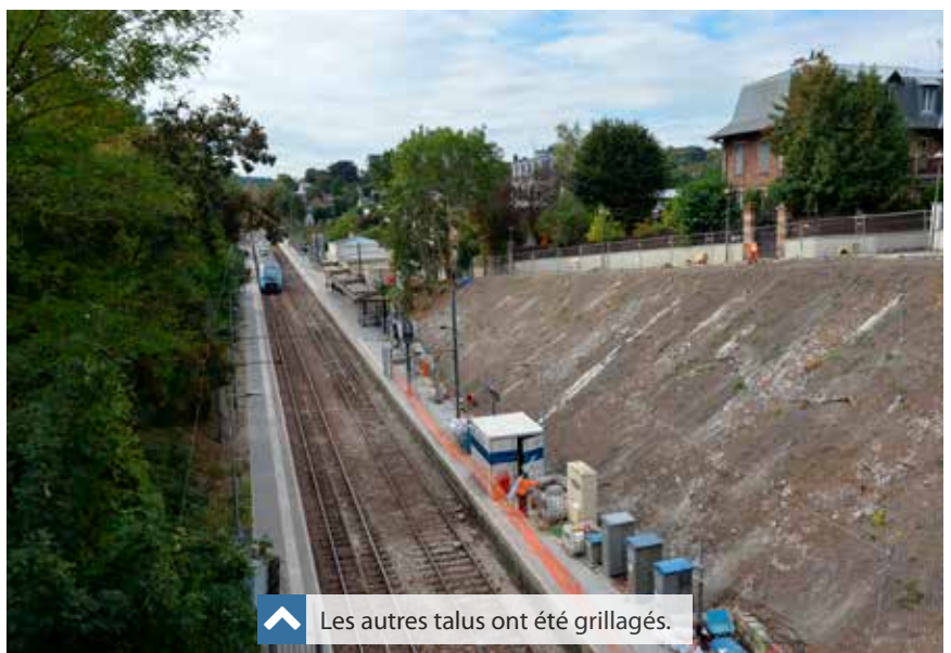
Les travaux de renforcement du talus sont terminés.
