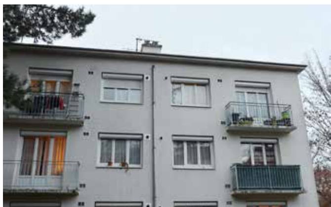
10, avenue du Beau-Site, 37 logements. Réhabilitation énergétique en cours.
