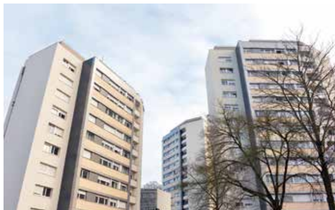
143-145, Grande Rue, 257 logements. Réhabilitation énergétique en 2015-2016.
