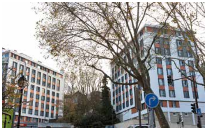
21-23, avenue de l'Europe, 105 logements. Réhabilitation énergétique en cours.
