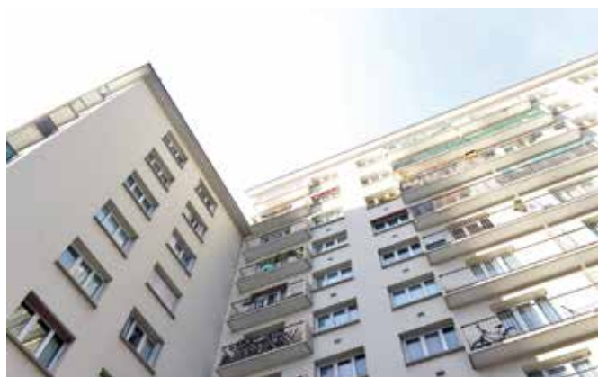
158, Grande Rue, 59 logements. Réhabilitation énergétique en 2019.
