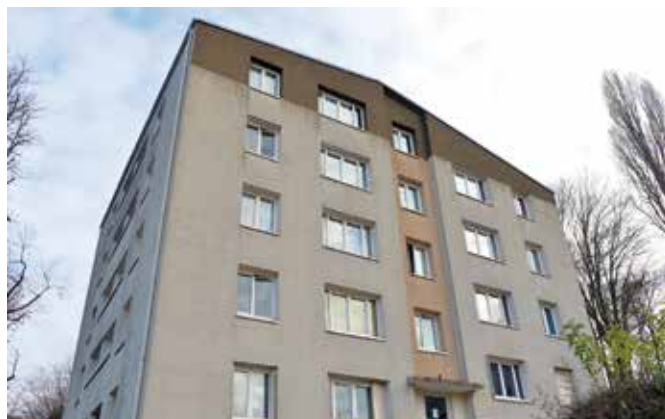
45-47, rue du Parc Cheviron, 36 logements. Réhabilitation énergétique en cours.
