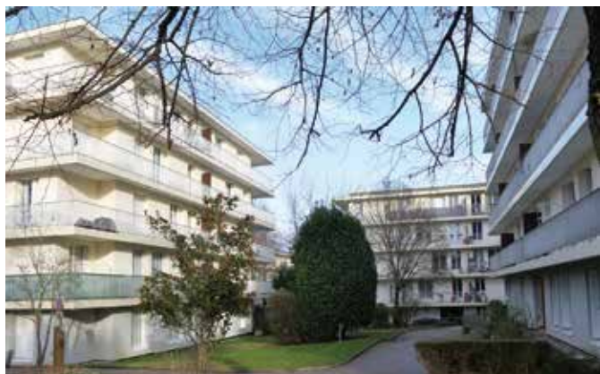
Postillon des Bruyères, rue de la Garenne, 102 logements. Réhabilitation énergétique en 2015.
