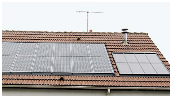
20 m 2 de panneaux photovoltaïques et 4 m 2 de panneaux solaires thermiques pour valoriser l'énergie solaire.
